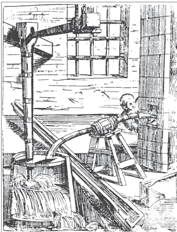
*Tromba idroeolica raffigurata nel manuale di Marco Antonio Della Fratta Montalbano “Pratica Medievale” del 1678, dove si vede la struttura di questa macchina che entra nei sistemi metallurgici nel corso del XVII secolo. Il sistema non prevede cinematismi ma unicamente una caduta d’acqua in un tubo verticale che finisce in una botte rovesciata dove il getto d’acqua con aria richiamata dalla depressione prodotta nella caduta s’infrange.*
