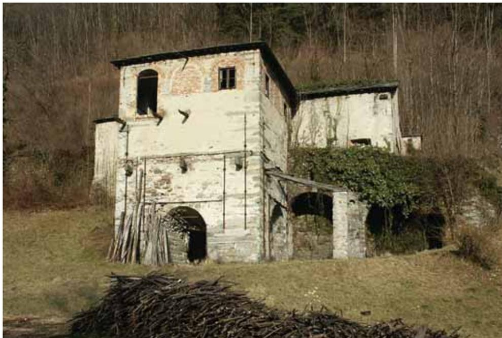
*Resti dell'altoforno settecentesco a carbone di legna di Meugliano (Piemonte). Le strutture sono conservate con i resti delle tettoie antistanti, il piano inclinato di accesso alla bocca e i retrostanti magazzini delle materie prime.*
