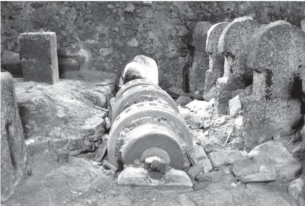
*Resti dell'impianto di una batteria di magli a testa d'asino del tipo terminale a Lessolo (Piemonte) lungo il vallone dell'Assa dove si aprono gli antichi cavi delle miniere di ferro. Lo scatto riprende i pesanti montanti litici dalla sede dell'albero motore di cui si vede il foro di passaggio. In testa la scritta incisa sul primo montante con il nome del proprietario e la data 1774. Al centro il varco dell'albero motore.*
