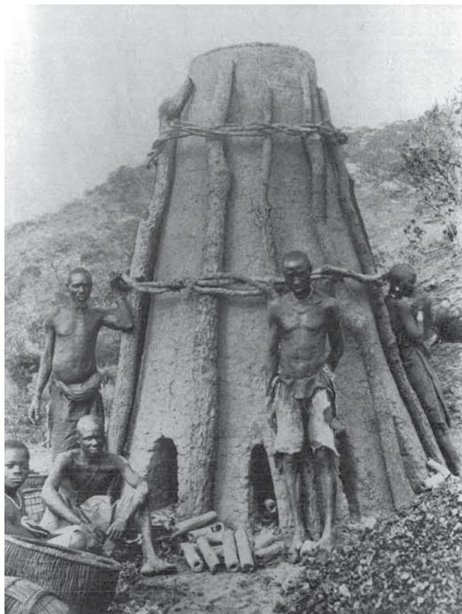
*Grande forno a camino del popolo Fipa in Tanzania al termine di un processo di produzione con il maestro e in suoi aiutanti. A terra le fistole fittili dei mantici. (Fotografia scattata nel 1914 da Wyckaert).*
