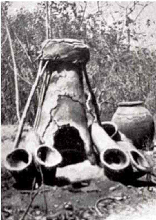
*Forno a camino con le strutture dei mantici a membrana con doppia camera, nella fotografia scattata dall'esploratore Eugène Lenfant nel 1902 in Camerun, dove si vedono l'apertura di scarico e le strutture di supporto della copertura. La similitudine di questo forno con quelli di VI - V secolo a.C. mostrati alle pagine precedenti è significativa.*
