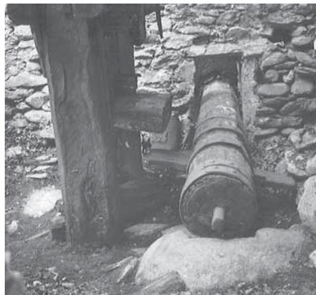
*(Sopra) Dettaglio dell'azionamento a camme della macchina ad asta singola battente, mossa da un albero motore mostrato dopo la spoliazione antica, con lo smontaggio del cuscinetto metallico alloggiato nel basamento sul quale ruotava il perno interno.*
