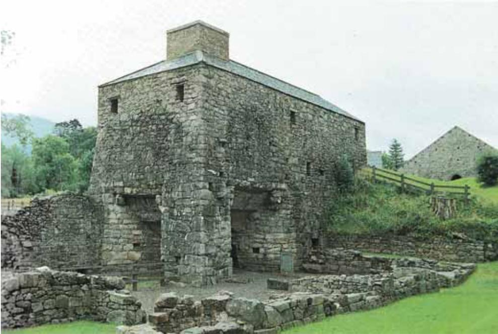
*Comprensorio produttivo siderurgico incentrato sull'altoforno a carbone di legna di Durban (Scozia Meridionale), con i resti delle strutture antistanti e sulla destra arretrato il grande magazzino delle materie prime.*
