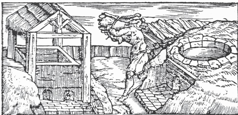
Calcara, secondo Vannoccio Biringuccio affine ai forni di arrostitimento dei minerali di ferro in un'incisione del *De la Pirotechnia*.
