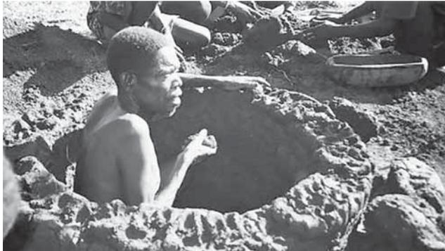
*Ricostruzione di un basso fuoco a camino con il corpo tronco-conico e crogiolo infossato presso Oska Denka nel sud-est dell'Etiopia (valle dell'Omo). Il metallurgista è nudo nel corpo del forno e ricostruisce la struttura con un impasto di argilla e scorie sminuzzate in granuli. A lavoro ultimato, prima di avviare il processo di riduzione sacrifica una capra e ne sparge il sangue sulle pareti. (Da Haaland 2004).*
