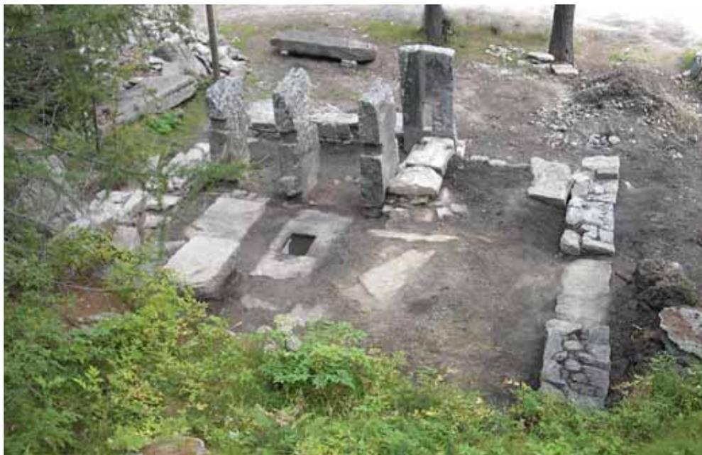
Resti della batteria di due magli a testa d'asino del tipo terminale nella ferriera di Ceresole Reale (Piemonte), il cui impianto è citato in un consegnamento del 1568: "...in finibus Cerixolarum... in la Fray... sive ad martinetum".
