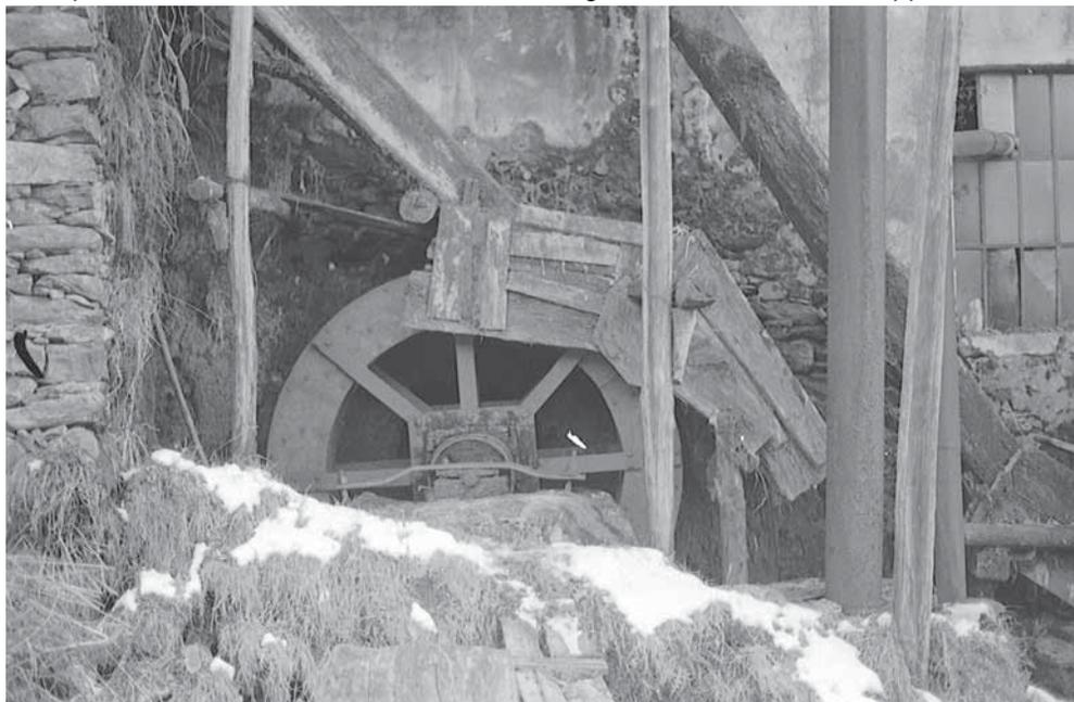
*Ruota idraulica dell’impianto ottocentesco di fucina da ferro (molendinum ferri) ancora discretamente conservato negli anni Ottanta del XX secolo. La struttura non è dissimile dagli impianti medievali. (Canischio Torino).*
